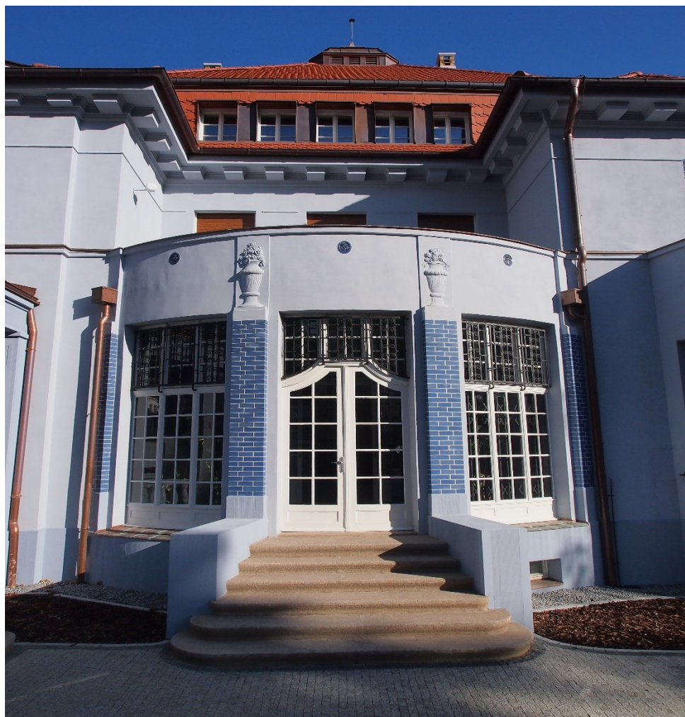
Průčelí nově zrekonstruované budovy „Diplomat“ v Chelčického ulici. Foto Jiří Jiráček.
